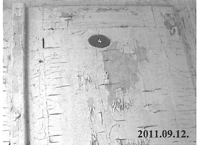
90.sz.kép:II.jelű épület szolgálati lakás 4. számú lakás bejárata
