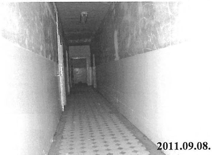
43.sz.kép: I. jelű kastélyépület I.em. folyosó
