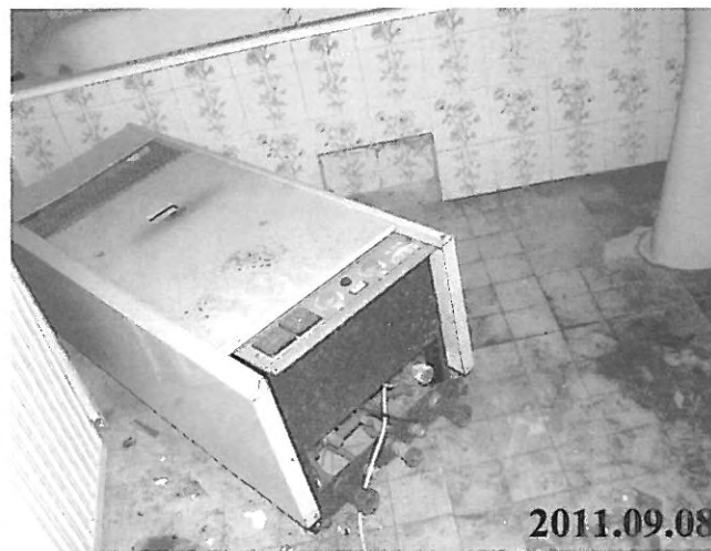
76. sz. kép: II. jelű épület szolgálati lakások, 1. számú lakás – fürdőszoba, WC
