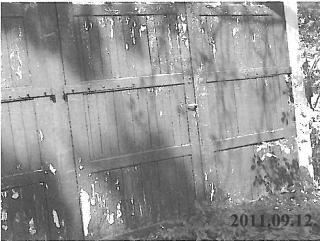
115. számú kép: IX. jelű épület: volt gépkocsi tároló bejárata
