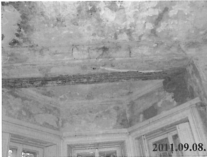
35. számú kép: I. jelű kastélyépület földszinti kórterem mennyezeti teraszbeázás
