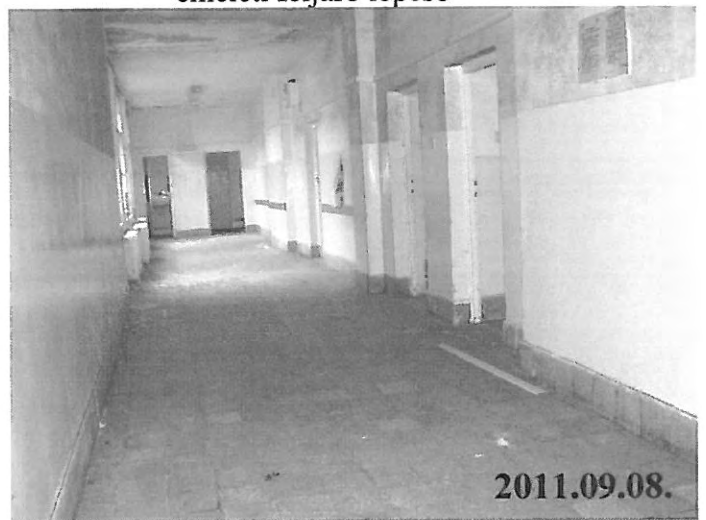
38.sz.kép:I.jelű kastélyépület I. em. folyosó
