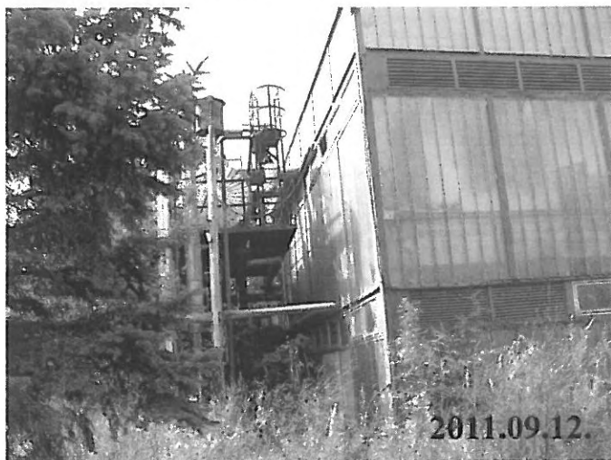
129. számú kép: XI. jelű épület: mosoda külső homlokzata
