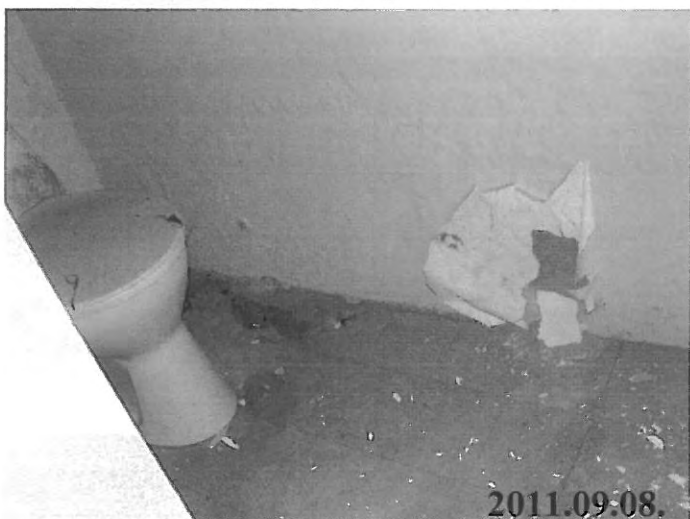
67. számú kép: II. jelű épület – rendelő, WC
