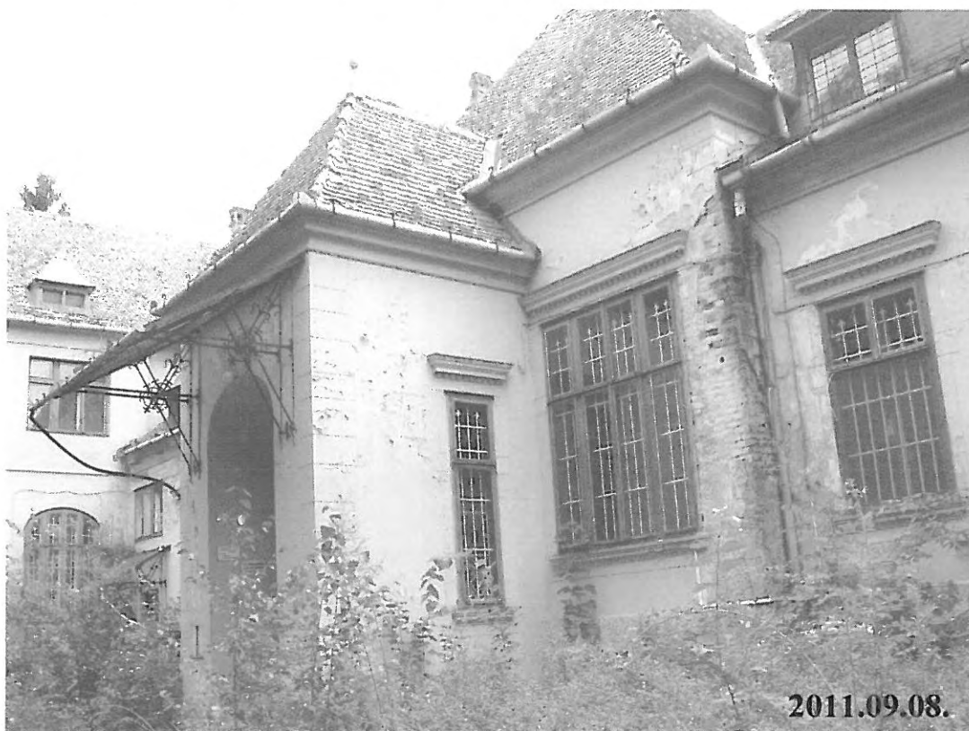
2. számú kép: I. jelű kastélyépület főbejárati – észak-nyugati homlokzatrésze
