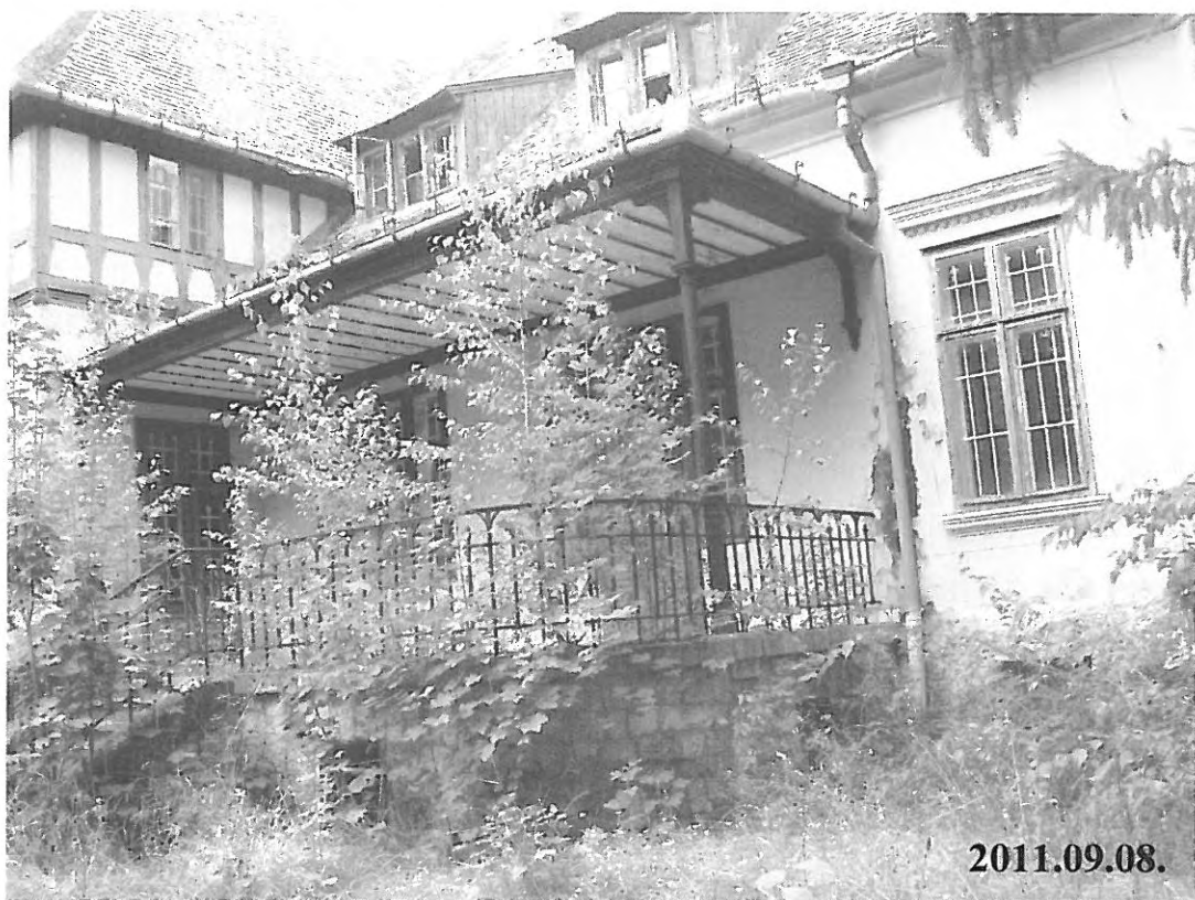
8. számú kép: I. jelű kastélyépület dél-keleti homlokzata fedett terasszal
