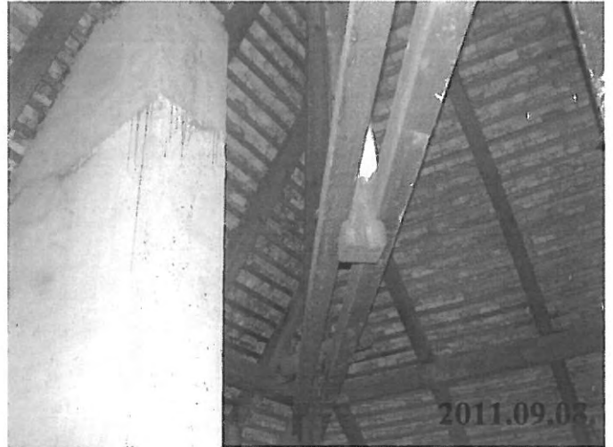
48.sz.kép:I.j. kastélyépület kötőgerendás két székállás rendszerű tetőszerkezet
