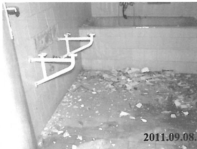
82.sz.kép:II.jelű épület szolgálati lakás 2.számú lakás – fürdőszoba, WC
