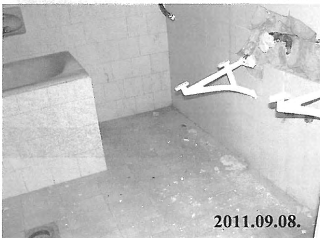
87.sz.kép:II.jelű épület szolgálati lakás 3.számú lakás – fürdőszoba, WC
