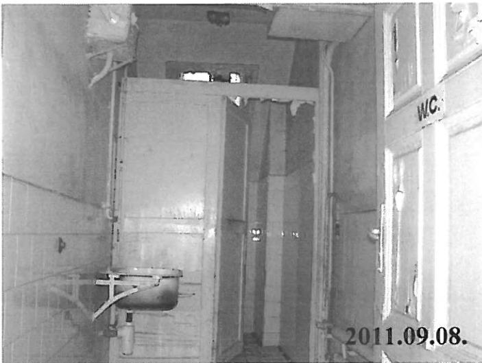
41. sz. kép: I. jelű kastélyépület I. em. WC blokk
