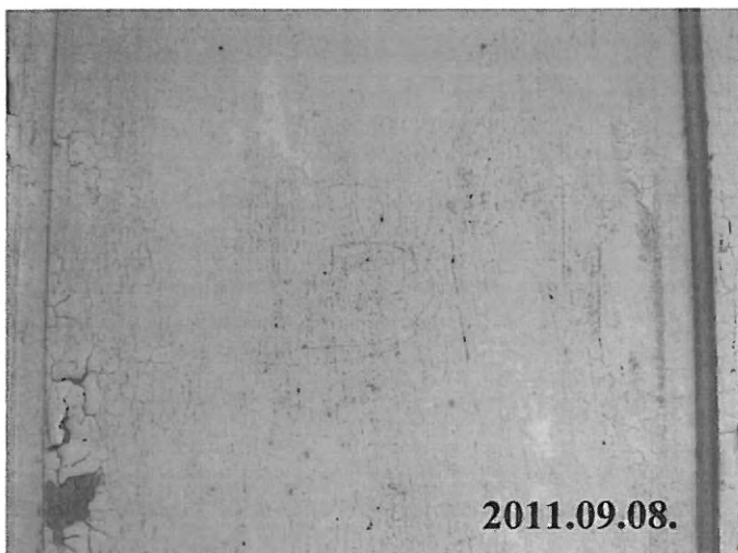
83. számú kép: II. jelű épület szolgálati lakás 3. számú lakás bejárata
