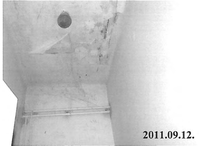
102.sz.kép:II.jelű épület szolgálati lakás 6. számú lakás – mennyezeti károsodás
