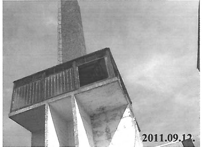
138.sz.kép:XV.j.ép.vasbeton műtárgy ráhelyezett kéménnyel, használhatatlan
