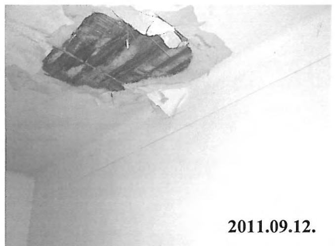
94.sz.kép:II.jelű épület szolgálati lakás 4. számú lakás – mennyezetkárosodás
