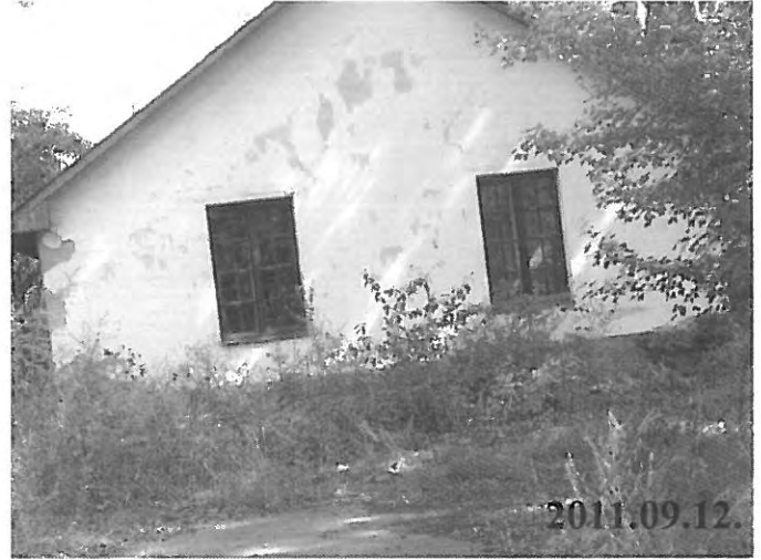
114. számú kép: IX. jelű épület: volt gépkocsi tároló homlokzata
