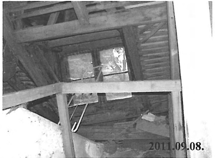
50.sz.kép:I.j.kastélyép.károsodott tetőszerkezet
