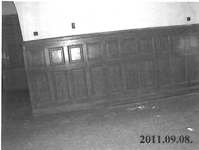
19. számú kép: I. jelű kastélyépület földszinti társalgó, oldalfalburkolat
