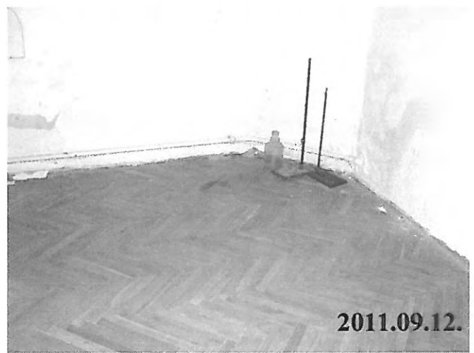
100.sz.kép:II.jelű épület szolgálati lakás 6. számú lakás – szoba
