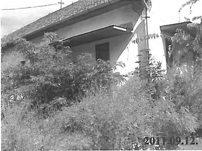
107. számú kép: IV. jelű raktárépület homlokzata
