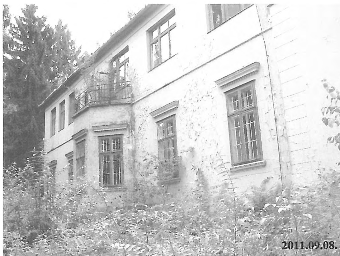
6. számú kép: I. jelű kastélyépület észak-keleti homlokzata
