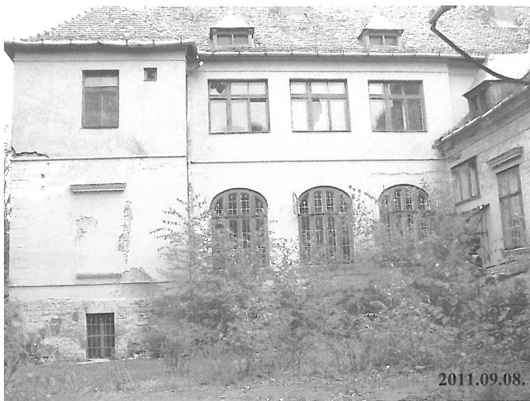
4. számú kép: I. jelű kastélyépület udvari homlokzata
