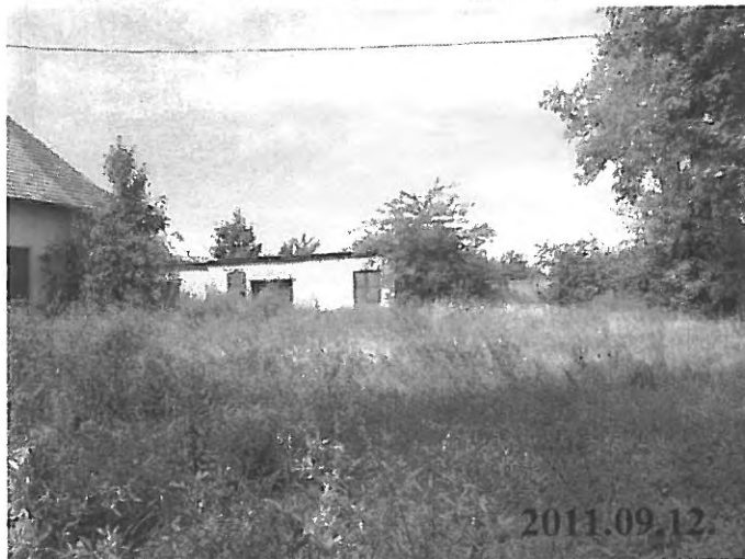
111. számú kép: VII. jelű épület: telekhatáron lévő raktár avult, károsodott
