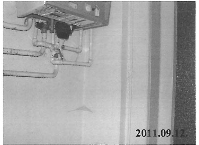
92.sz.kép:II.jelű épület szolgálati lakás 4. számú lakás – fürdőszoba
