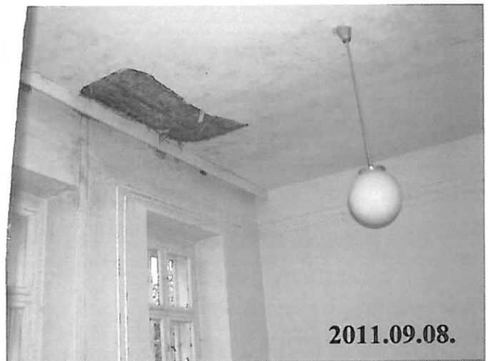
64.sz.kép:II.j.ép.rendelő károsodott mennyezete
