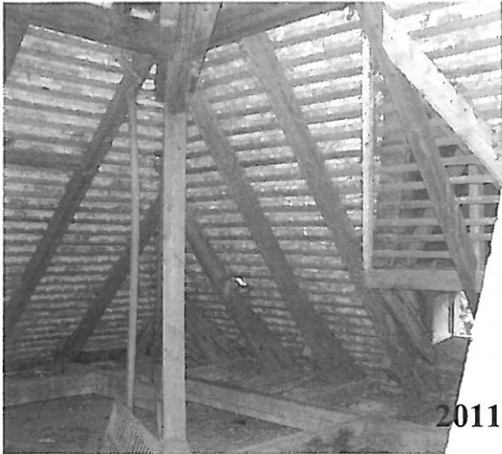
47. sz. kép: I. jelű kastélyépület kötőgerendás két székállás rendszerű tetőszerkezet
