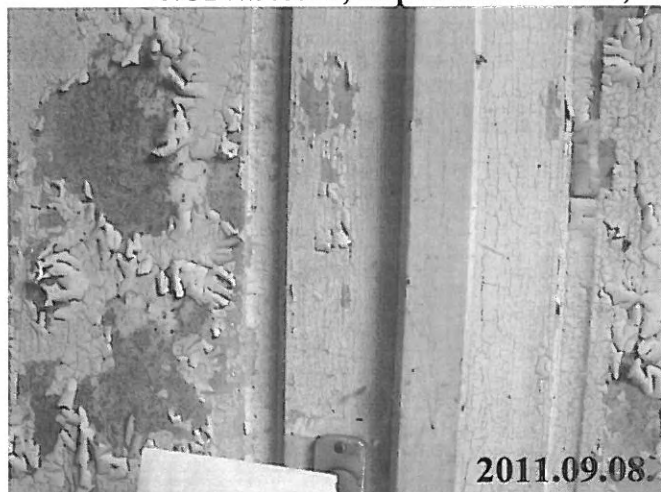
77. számú kép: II. jelű épület szolgálati lakás 2. számú lakás bejárata
