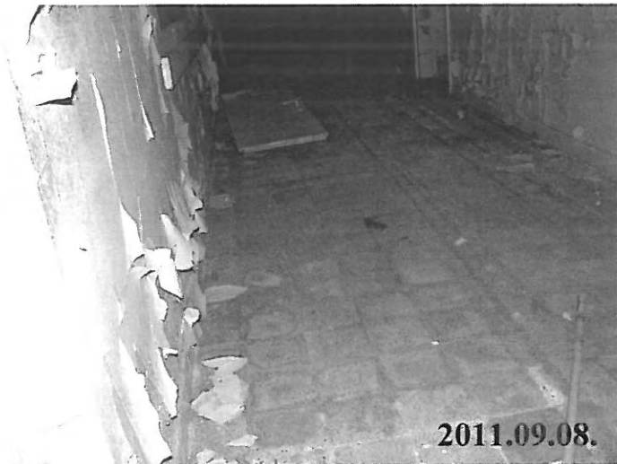
53. sz. kép: I. jelű kastélyépület – alagsor, folyosó
