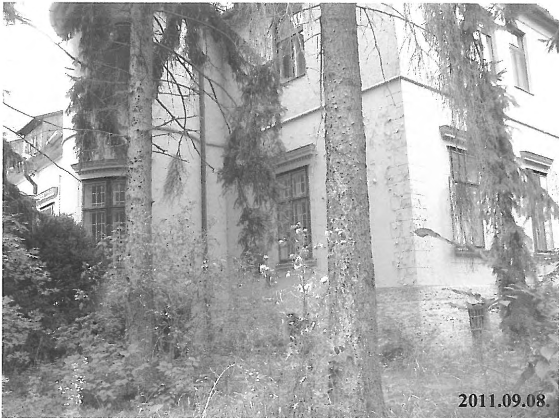
7. számú kép: I. jelű kastélyépület dél-keleti homlokzata
