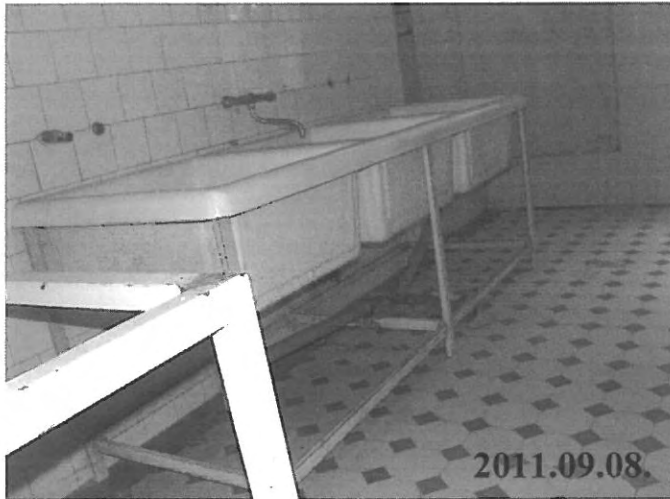
23. számú kép I. jelű kastélyépület fszt. tálaló
