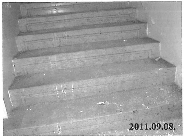
36. számú kép: I. jelű kastélyépület emeleti feljáró lépcső
