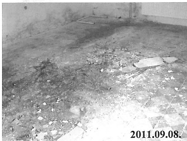
75.sz.kép:II.jelű épület szolgálati lakások 1.számú lakás – szoba, felbontott padlószőnyeg, alatta mozaiklap
