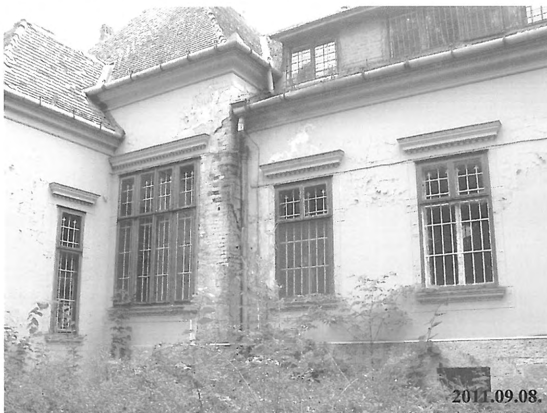
3. számú kép: I. jelű kastélyépület udvari homlokzata
