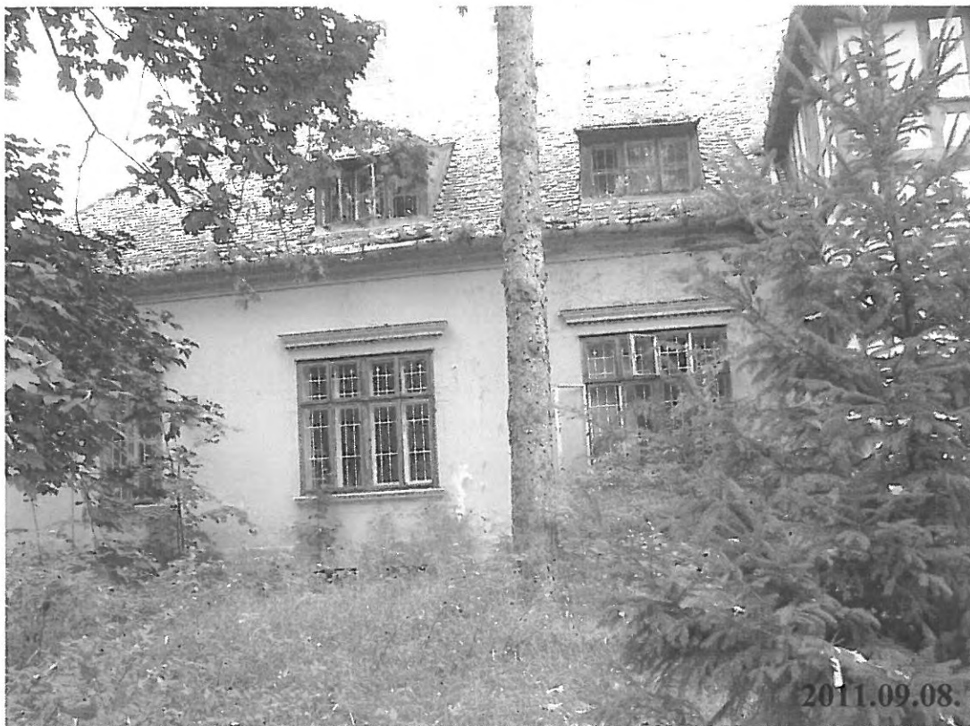
9. számú kép: I. jelű kastélyépület dél-nyugati homlokzata
