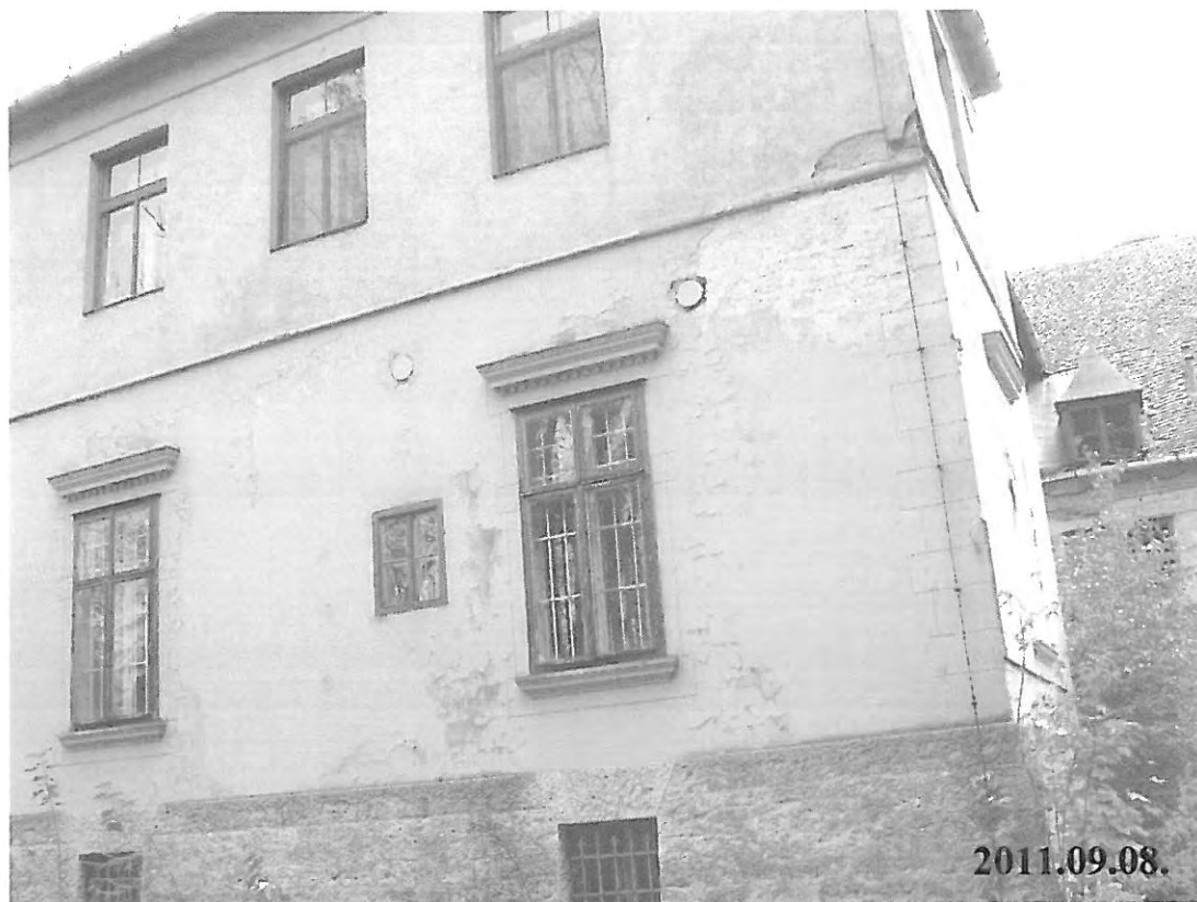
5. számú kép: I. jelű kastélyépület észak-keleti homlokzata
