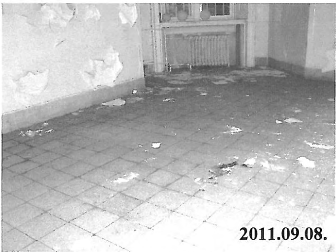
31. sz. kép: I.jelű kastélyépület földszinti kórterem
