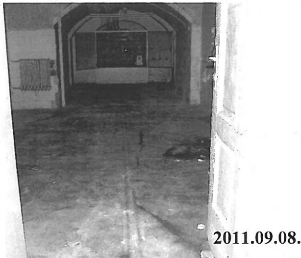
57.sz.kép:I.j.kastélyép. alagsor, volt kazánház
