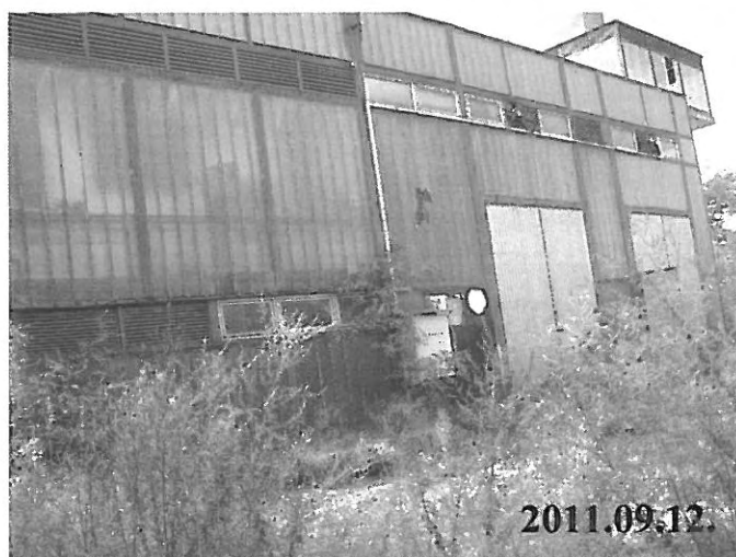
128. sz. kép: XI. jelű épület: mosoda kazánház felőli homlokzata
