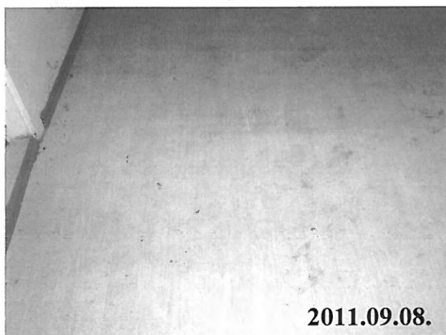
73.sz.kép:II. jelű épület szolgálati lakások 1. számú lakás – közlekedő
