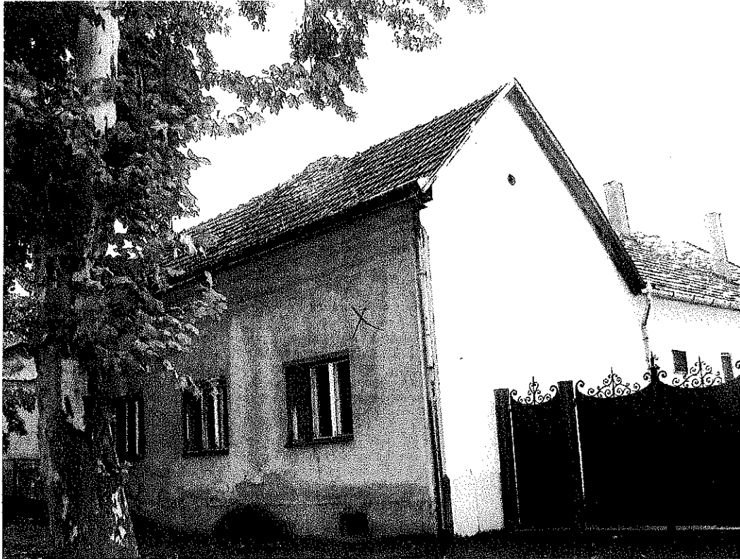
3. számú kép: utcai és oldalhatári homlokzat, az oldalhatári homlokzatot a szomszéd tulajdonos felújította
