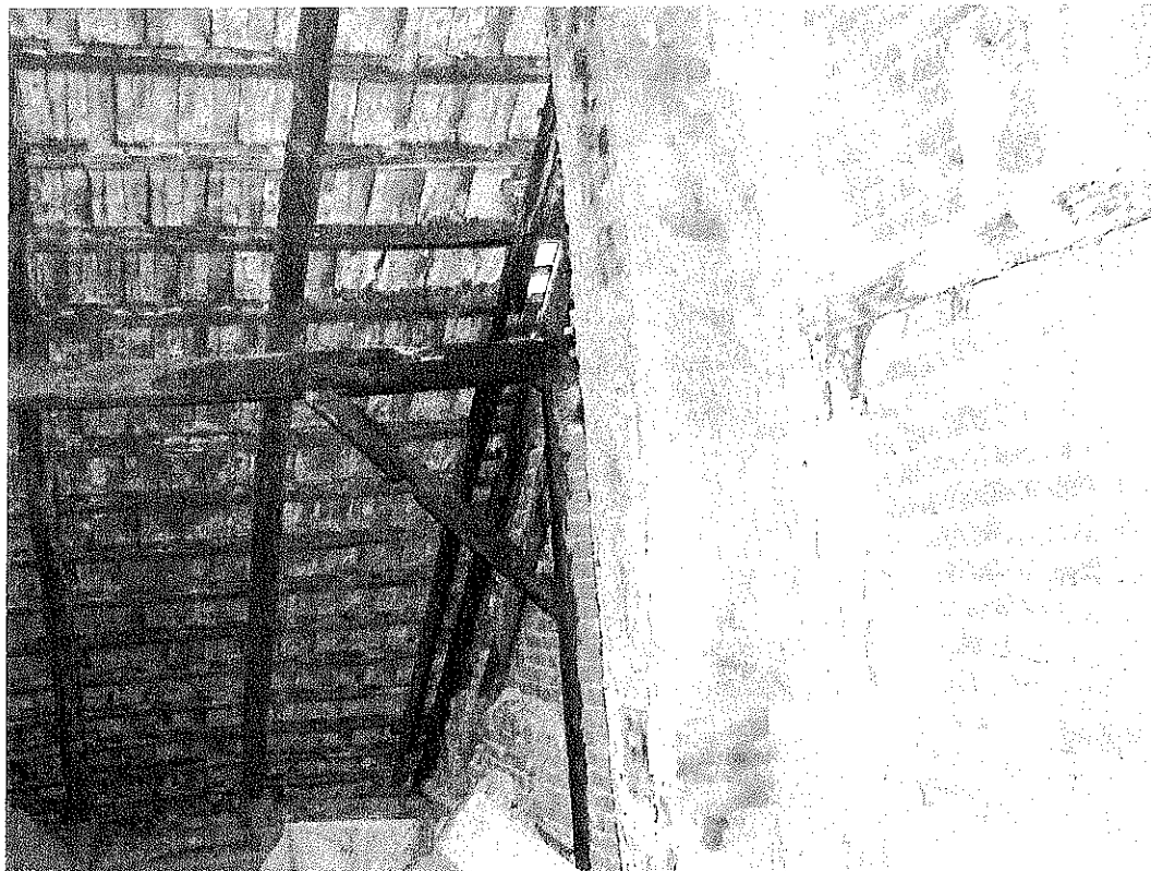
7. számú kép: padlástér – károsodott szaruzat, lécezés, szú ette, cseréphiányos
