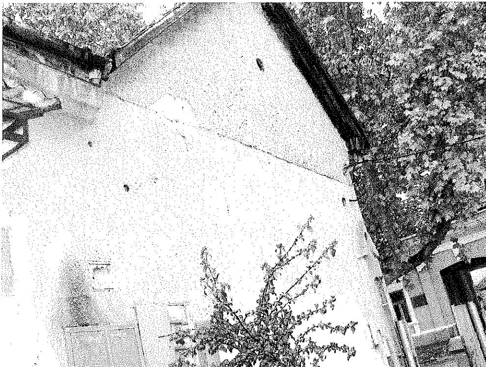
13. számú kép: I. jelű lakrész – udvari homlokzat, károsodott tűzfal, siktól való eltérése balesetveszélyes
