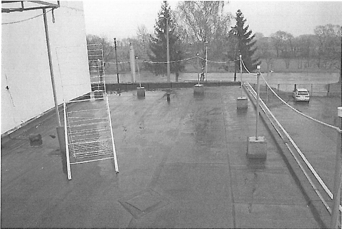
A földszint fölötti tető palazúzalékos lemezfedéssel felújítva
