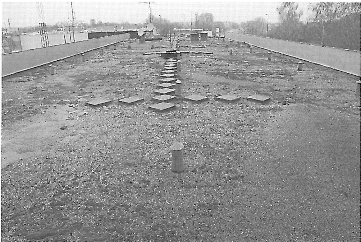
Az emelet fölötti tető az eredeti kavicsolt lemezfedéssel
