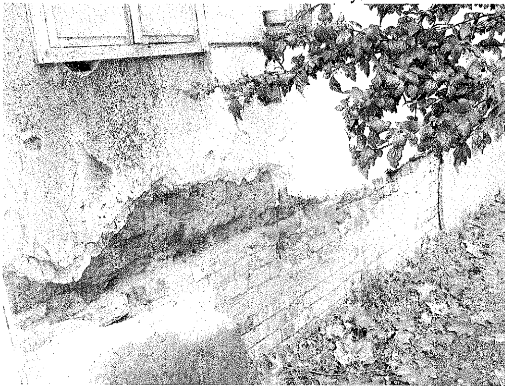
14. sz. kép: I. jelű lakrész – bejárat, a téglalábazat és vályogfal a szigetelés hiánya miatt károsodott, avult
