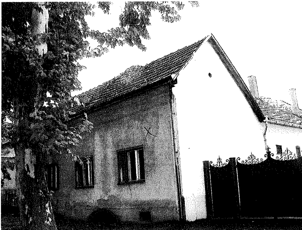
3. számú kép: utcai és oldalhatári homlokzat, az oldalhatári homlokzatot a szomszéd tulajdonos felújította
