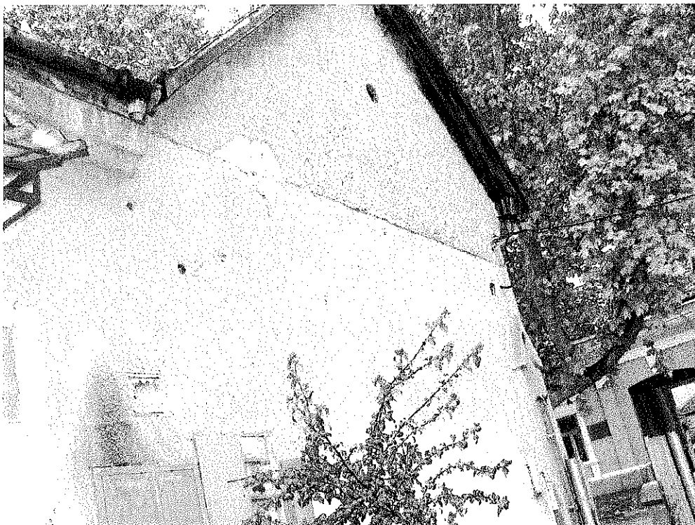
13. számú kép: I. jelű lakrész – udvari homlokzat, károsodott tűzfal, síktól való eltérése balesetveszélyes
