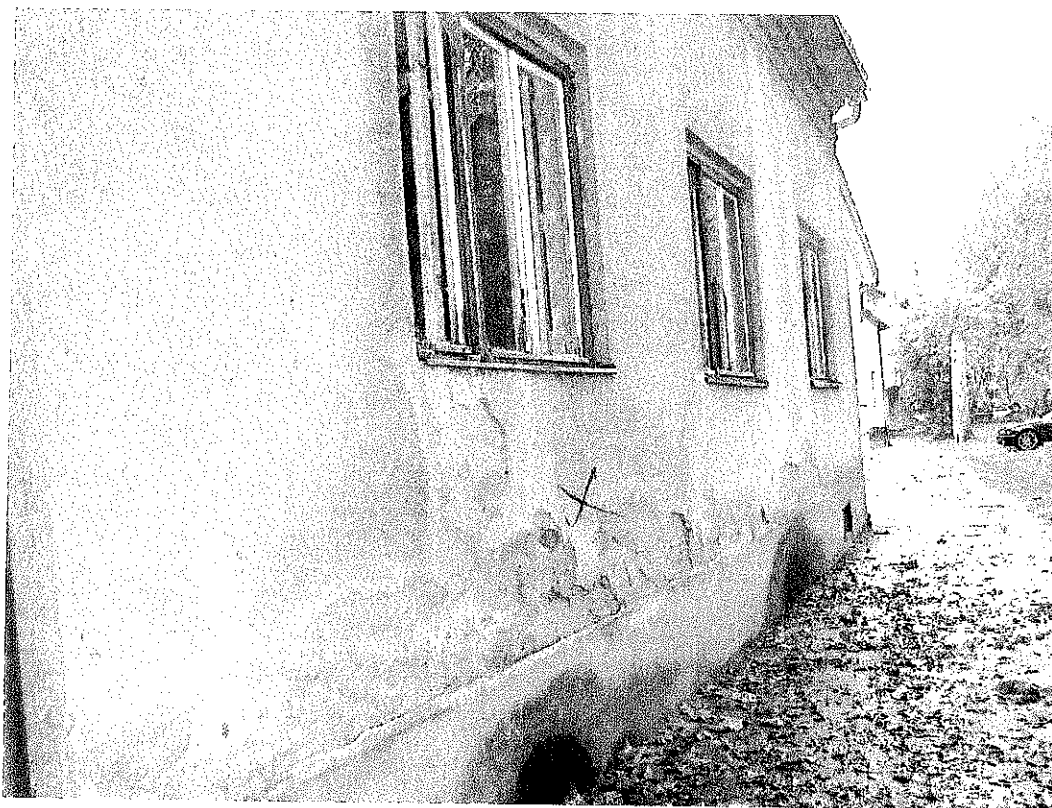
1. számú kép: utcai homlokzat
