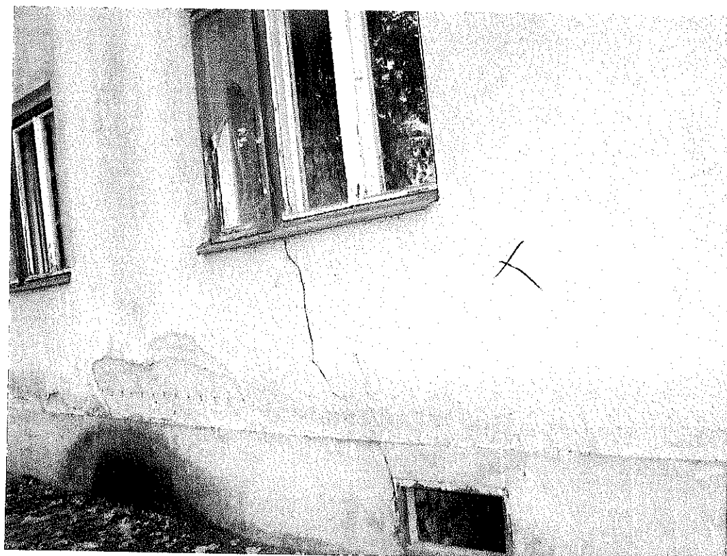
2. számú kép: utcai homlokzat
