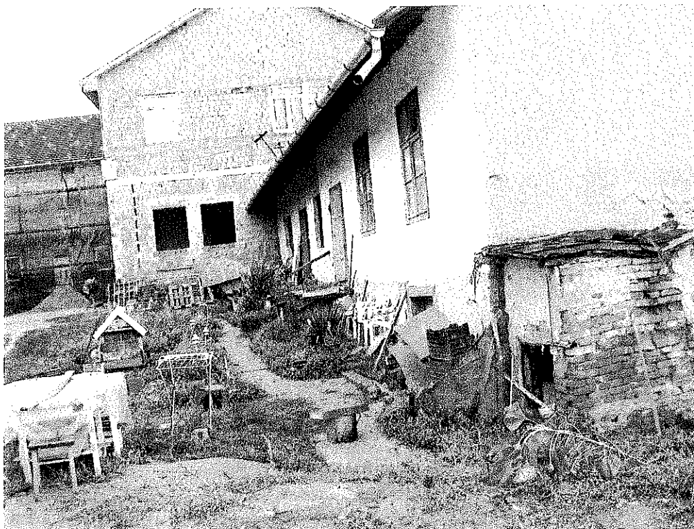
3. számú kép: udvari és hátsókerti homlokzat, de az utcafronton társasházi lakásépítés folyik
