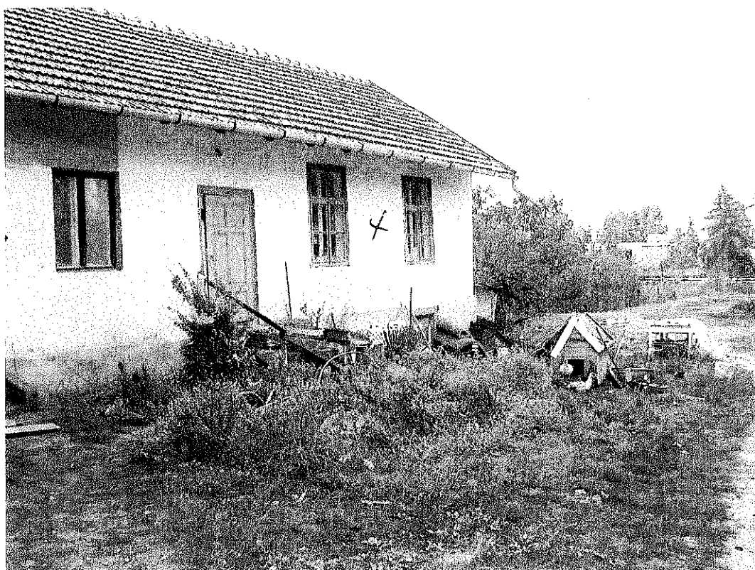
1. számú kép: udvari homlokzat
